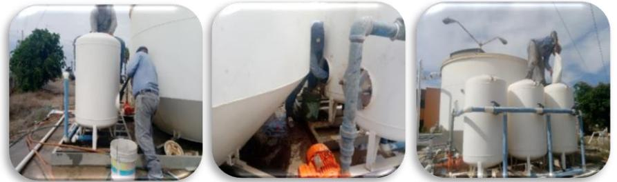
**Figura 18.** Cambio de cargas en filtros de planta potabilizadora.
