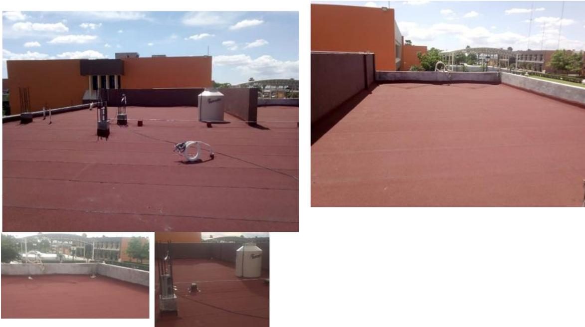
**Figura 11.** Impermeabilización del Edificio Cultural.
